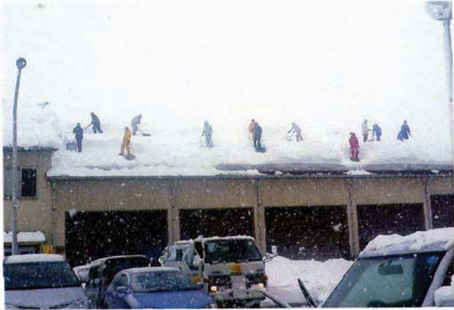
▲降り続く雪にもまげず作業中!!
